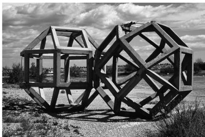
1980 Anonyme. Modèle de brise-lame expérimental. Béton armé, 230 x 230 x 230 cm. Sud de la France. (c) R.Z.
